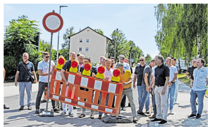
Als Hauptverkehrsader kommt der Becksteiner Straße in Lauda eine große Bedeutung zu. Nach einer Bauzeit von knapp zwei Jahren ist sie wieder befahrbar. BILD: SEUFERT
