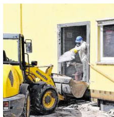
Das Gebäude wird zunächst entkernt.
