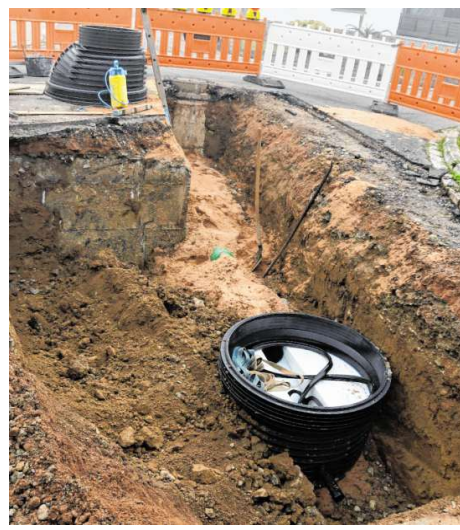
Der Kanalanschluss in der Beethovenstraße liegt bereits.
