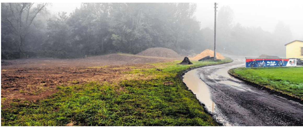
Noch liegt das Gelände rund um den alten Sportplatz in Unterbalbach im Nebel. In Kürze werden die Bagger anrollen, um den Anschluss des Sportheims an das städtische Kanalnetz zu verlegen. Danach wird auch der Radweg erneuert. Die Retentionsfläche als Ausgleichsmaßnahme ist fast fertig. BILDER: DIANA SEUFERT
