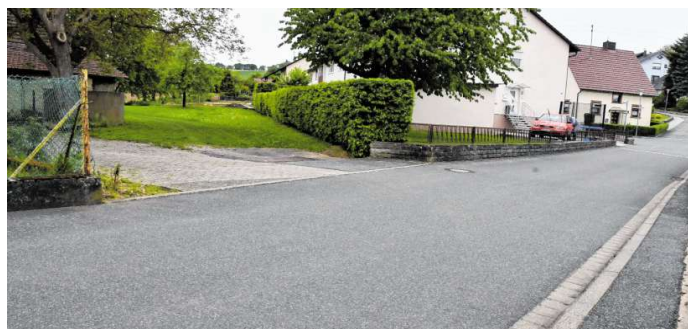
Weil bei Starkregen das Wasser über die Bienenstraße in Heckfeld schießt, hat der Technische Ausschuss grünes Licht für die Umbaumaßnahmen am Einlaufschacht für die Außengebietsentwässerung gegeben.
