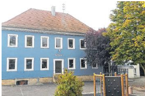
Die „Balbachschule“ ist eine Grundschule mit Kernzeitbetreuung.
