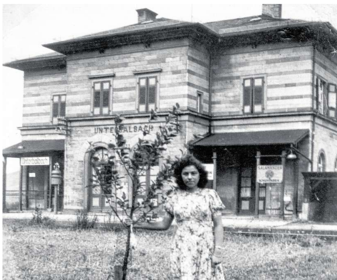
Rita Schreck 1950 vor dem Haltepunkt Unterbalbach. Das Gebäude war bis 1. Oktober 1961 in Betrieb. BILDER: SAMMLUNG UWE BÜTTER
