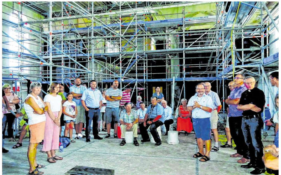
Mehr als 60 Interessierte nahmen an der Baustellenführung in der St.-Markus-Kirche in Unterbalbach teil.
