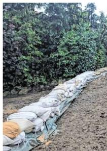
In Unterbalbach errichteten Feuerwehr und Technisches Hilfswerk aus 2000 Sandsäcken eine Barriere, um den Ort vor weiteren Erdrutschen von einem erodierten Acker zu schützen (linkes Bild). Im Ort musste viel Schlamm geschöpft werden (mittleres Bild). Teils floss das Wasser einen halben Meter hoch durch die Straßen (rechtes Bild).
