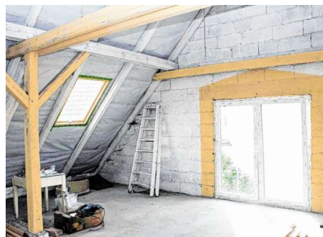
Auf dem ehemaligen Scheunenboden ist ein Aufenthalts- und Gemeinschaftsraum vorgesehen.
