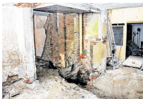
Sanierung der Innenräume inklusive Freilegung und Erneuerung der Sanitär- und Elektroleitungen.
